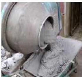
La miscelazione avviene in betoniera dopo aver aggiunto il quantitativo d'acqua riportato in scheda tecnica.
