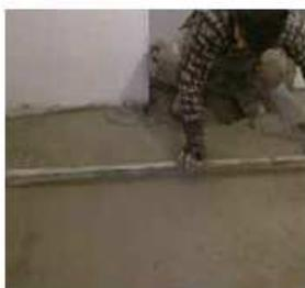
Utilizzando una tradizionale staggia, si procede al livellamento del massetto sfruttando le fasce precedentemente realizzate.
