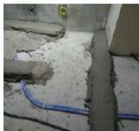
Utilizzando Diathonite Massetto, vengono realizzate le fasce di riferimento per lo spessore complessivo.
