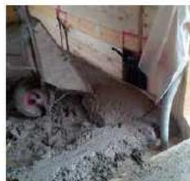
Diathonite Massetto viene direttamente gettata sul solaio o sulla copertura su cui si intende realizzare il massetto.
