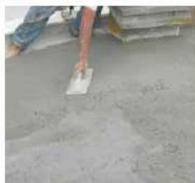
Utilizzando un frattazzo, si rifinisce la superficie del massetto per prepararla alla posa della pavimentazione.
